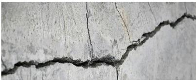
Beaucoup de poids repose sur les murs en brique, les fondations s'affaissent et des fissures apparaissent.
